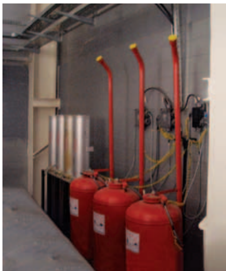
Рис. 2. Комбинированная установка КУП «аэрозоль + порошок» ГПА 66ГЦ-1162 АО «СибурТюменьГаз», расположенная в свободных зонах укрытия объемом 3860 м 3
