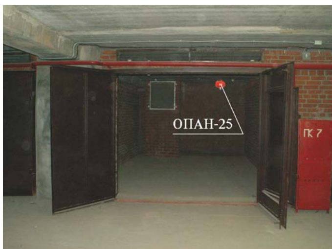
Рис. 4. Расположение модуля ОПАН-25 в боксовой стойке.
