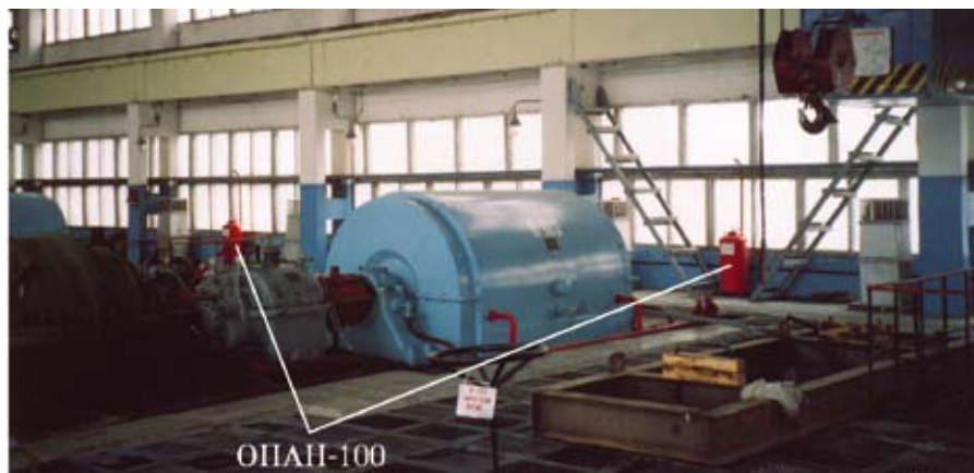
Рис. 4. Автоматическая система противопожарной защиты компрессорного цеха завода «Пермнефтегазпереработка» (г. Пермь)
